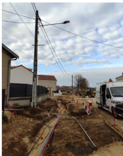
travaux concernant l'enfouissement du réseau basse tension ainsi que l'installation de coffrets sur le domaine public et l'enlèvement des poteaux en béton. Début des travaux en septembre, fin du chantier prévu au 1<sup>er</sup> trimestre 2021. Les luminaires led démontés seront récupérés et reposés dans d'autres secteurs en lieu et place des lampes à sodium plus énergivores.
