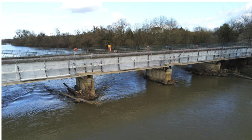
■ Travail au-dessus du milieu aquatique avec mise en place d'un platelage sous l'ouvrage pour isoler la zone de travaux du reste de l'environnement.
