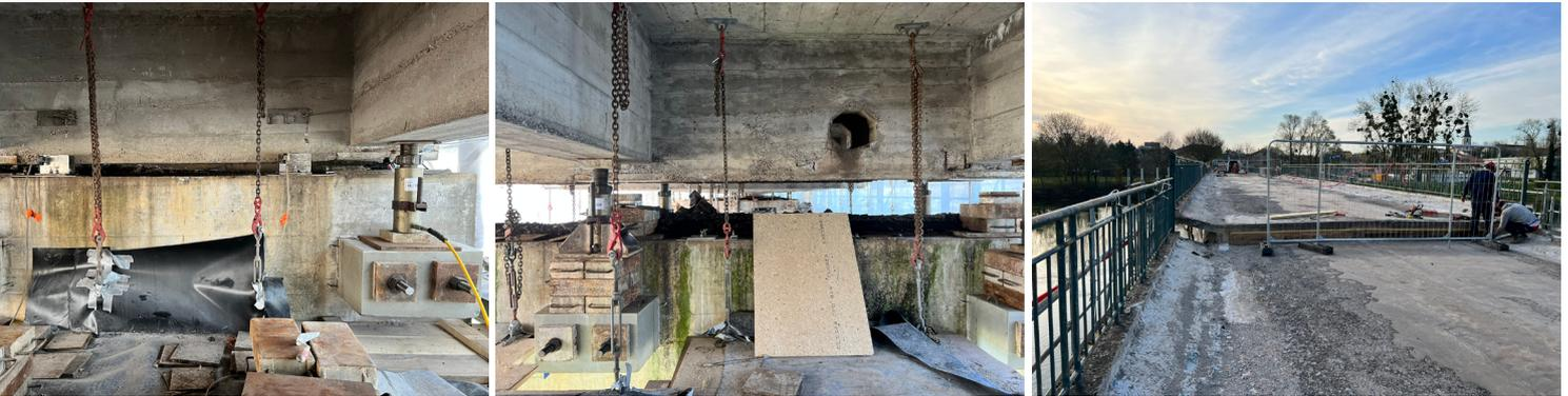
Cela permet de dégager les entretoises et têtes de piles pour réaliser les travaux.
